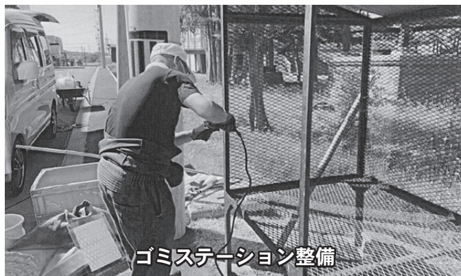
ゴミステーション整備
